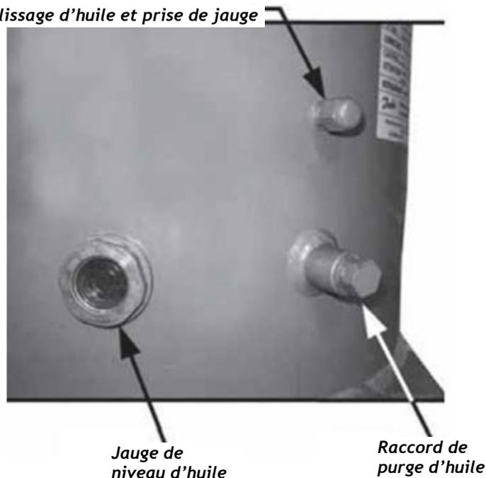
En cas d'échauffement du moteur électrique ou de défaillance du compresseur, un test s'impose pour contrôler l'acidité de l'huile lubrifiante. Ensuite, il convient de nettoyer le circuit pour réduire cette acidité et atteindre une valeur plus adaptée, en installant, par exemple, un filtre anti-acidité et en changeant l'huile du circuit.
